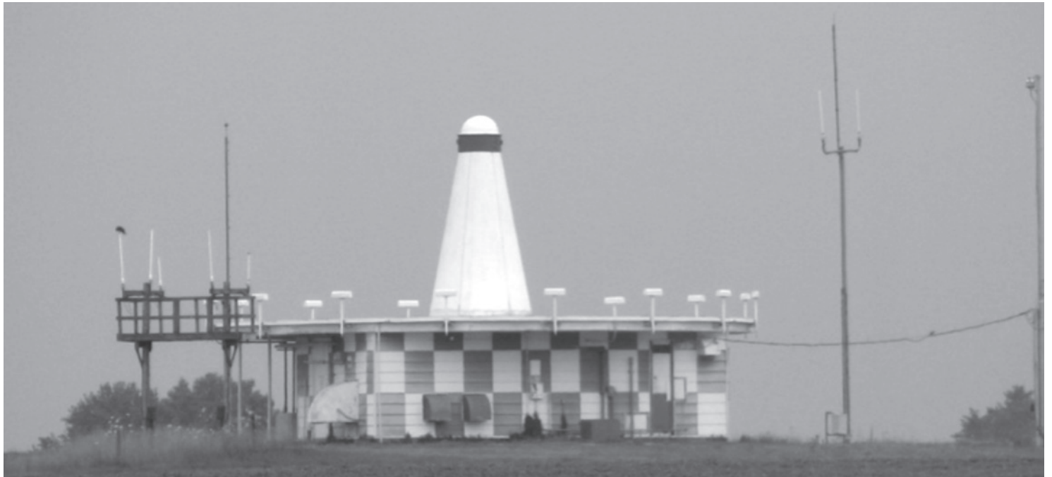
Estação VOR, semelhante à do Aeródromo de Maputo que se encontra instalada em Magoanine A. O VOR de Maputo (VMA) transmite nos 112.3 MHz. Os pilotos do Tupolev presidencial seleccionaram a frequência do VOR de Matspaha (112.7 MHz) por engano. O Co-piloto não conferiu o indicativo do VOR de Maputo pois estava distraído a escutar o noticiário e música da Rádio Moscovo, e o Comandante não cumpriu com os regulamentos obrigatórios de verificação das listas, ou «Checklists», de descida e aproximação, ocupando-se em vez disso de questões estranhas ao voo.
