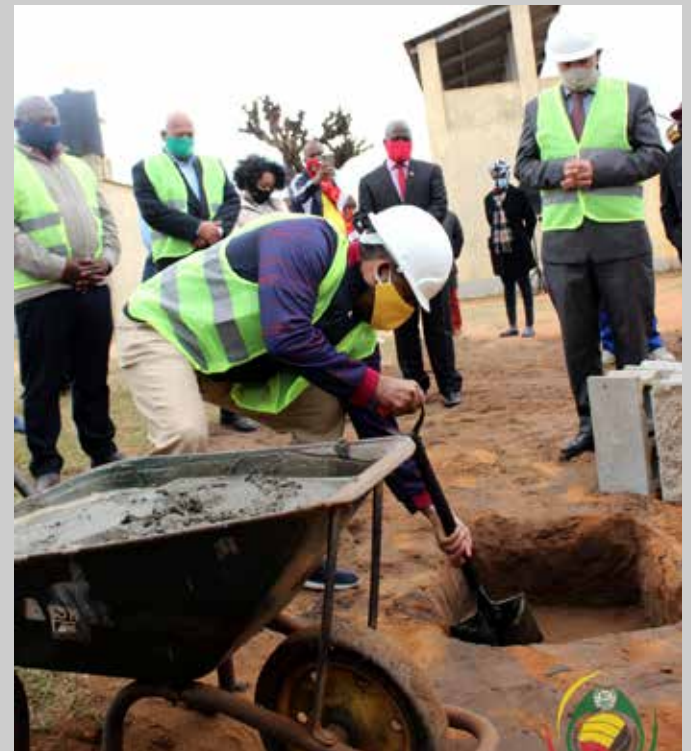
Lançamento do primeiro bloco
