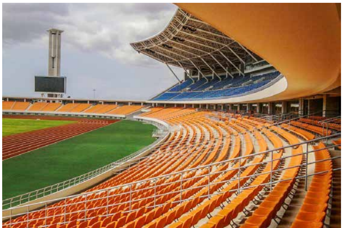
Estádio Nacional do Zimpeto em degradação acentuada
