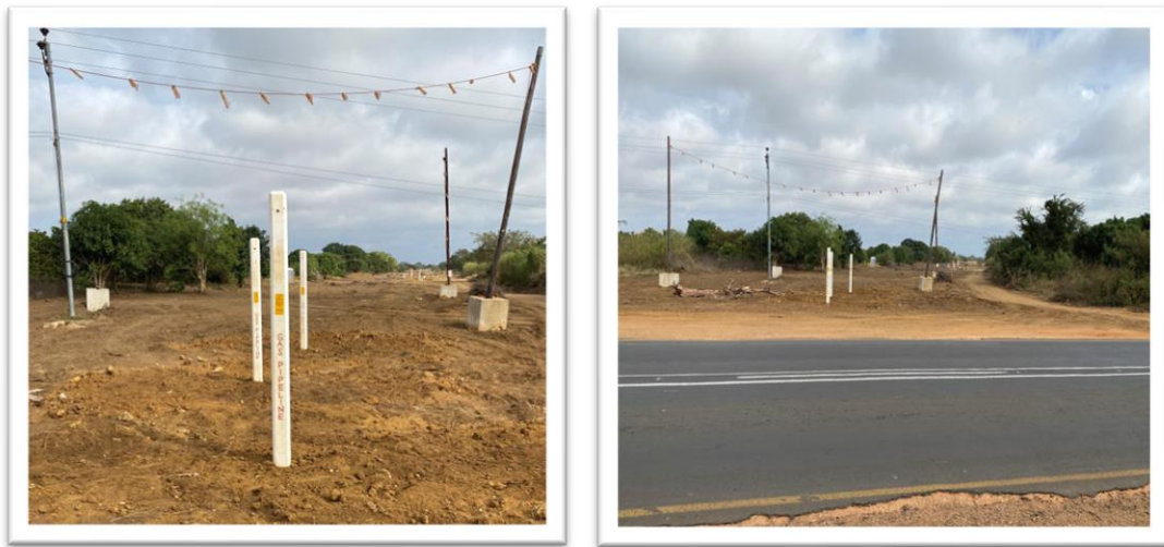
Foto: Pipeline recentemente construído, Maimelane, Inhassoro, Julho 2023.
