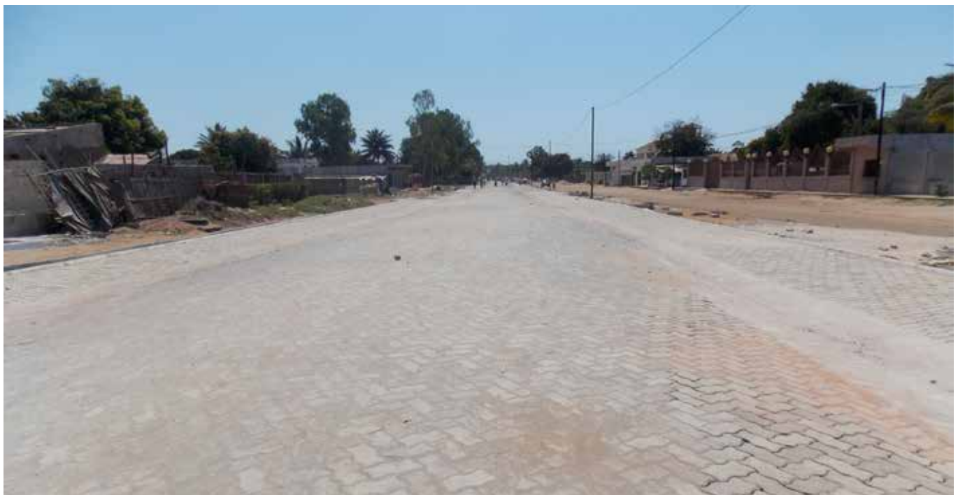
Rua dos 40 metros no bairro de Muhala expansão
