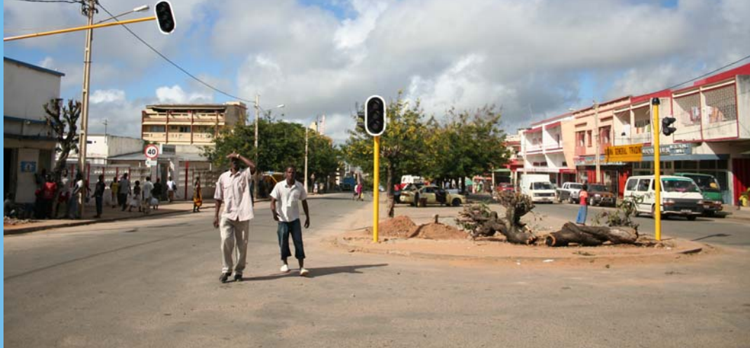
Algumas árvores tiveram de ser derrubadas para a colocação de semáforos, junto ao cruzamento do Mercado (Avenida Paulo Kankhomba e Rua Monomotapa)
