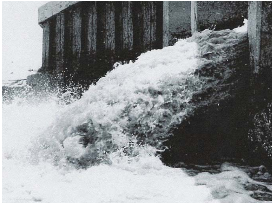
Imagem de Desaguadouro da Beira em 1967 após 5 anos de Obras de Drenagem e Saneamento da Cidade da Beira e da Região Suburbana: - Descarga de Cheia por uma das bocas em baixa-mar vista por Jusante (direcção por onde correm as águas para o mar)
