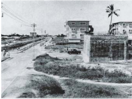
Canal A II ao meio da Av. Almirante Sarmiento Rodrigues, Posto de Bombagem nº11. (Actual Av. 24 de Julho)
