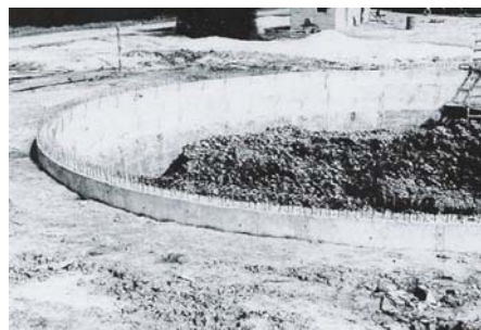
Construção da Estação Elevatória nº 4 e descida do Anel Gigante de Betão. (Segunda fase).
